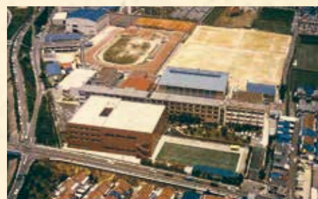
1985(昭和60)年頃学園全景(茨木学舎)
